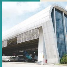
Gedung Hanggar PT GMF AA Bandara Soekarno Hatta
