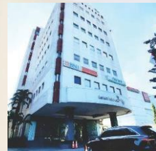
Gedung Garuda Gunung Sahari
